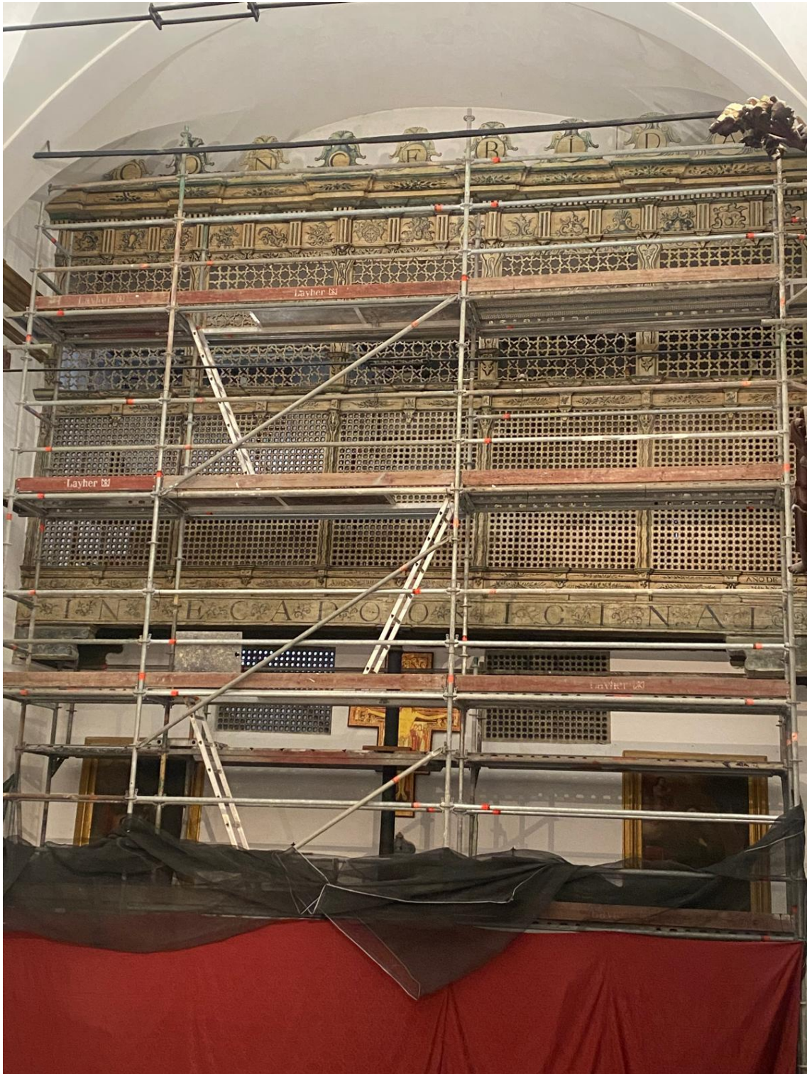
Se realizan fotos del estado actual de la celosía
