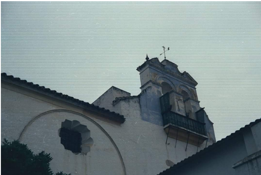
Ilustración VII: Antigua espadaña del convento demolida en 1976 junto con el coro de la capilla, para realizar la construcción de viviendas. Posteriormente fue reconstruida y ubicada en la actual capilla
